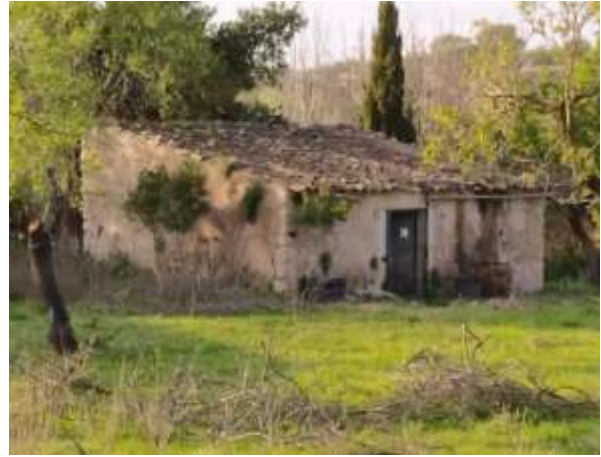
Imatge 17. Edificació existent.
