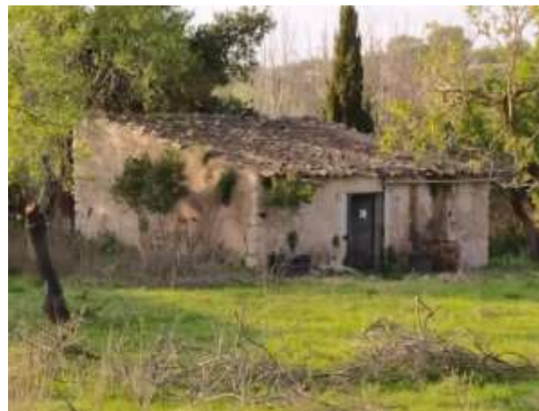
Imatge 12. Edificació existent.
