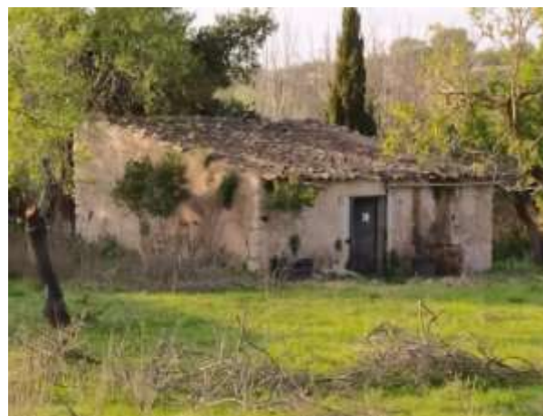
Imatge 4. Edificació existent.
