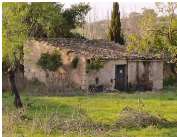
Imatge 25. Edificació existent.
